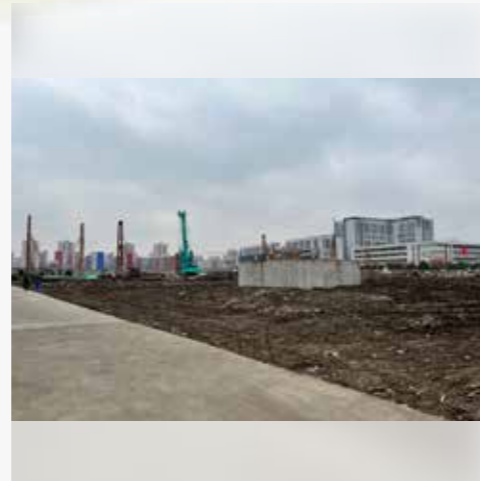
针对安全风险对基建项目现场施工安全管理情况进行取证
